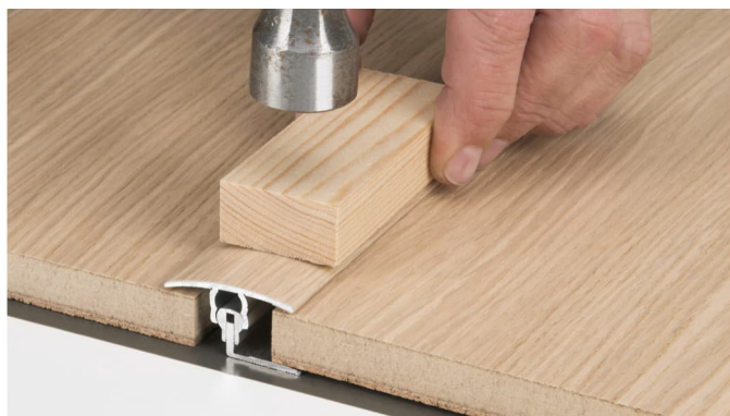
Instalace přechodového profilu hliníkového
