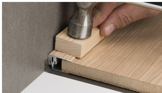
Instalace ukončovacího profilu hliníkového
